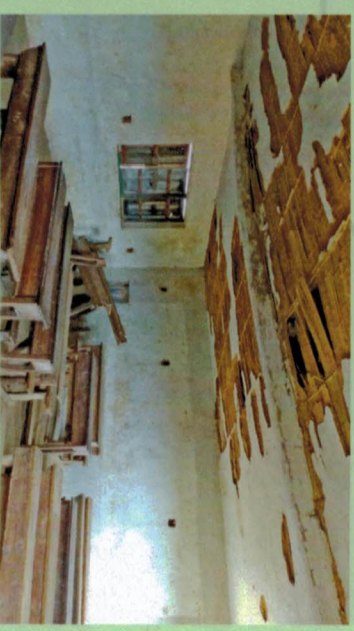
Réfection frisette salle de classe collège Stanislas
