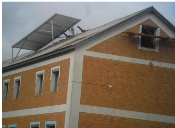
PANNEAUX SOLAIRES & FILS CONDUCTEURS INSTALLES
